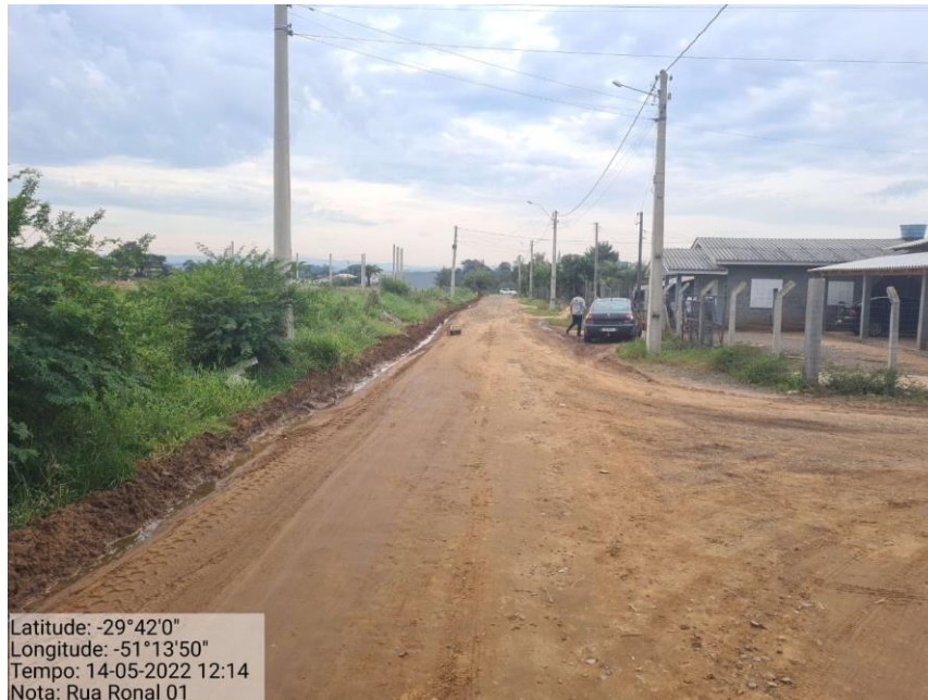
Foto 3: Rua Ronal J. Ruaro Meneghi - Início do trecho
